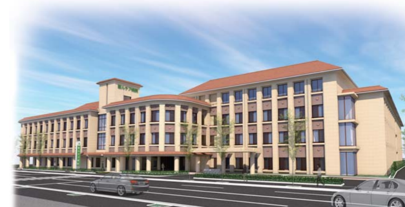
2021年春に病院全体が完成する
